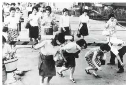
受贈 10 東海道線踏切改良工事写真アルバム
