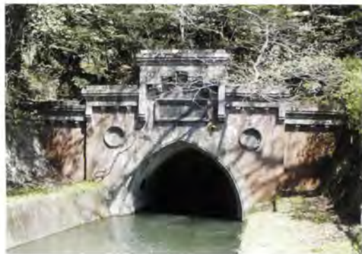
第2トンネル西口
