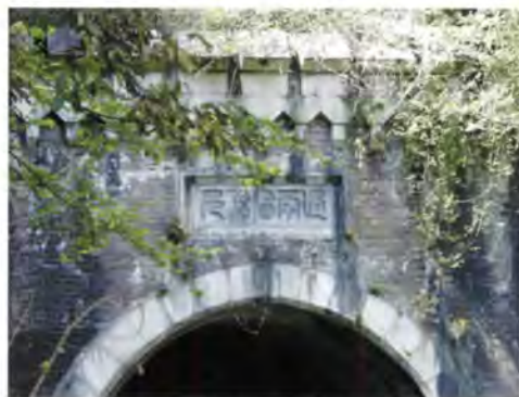
第3トンネル東口 扁額（へんがく）
