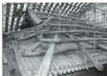
葛川明王院本堂屋根修復風景
