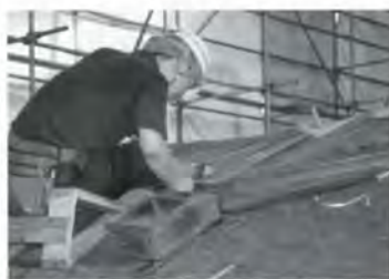
園城寺金堂屋根修復風景
