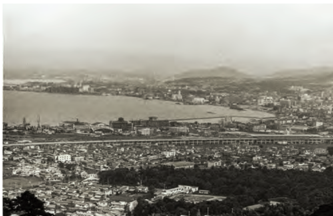
山中越から西大津駅を望む 昭和51年8月撮影
